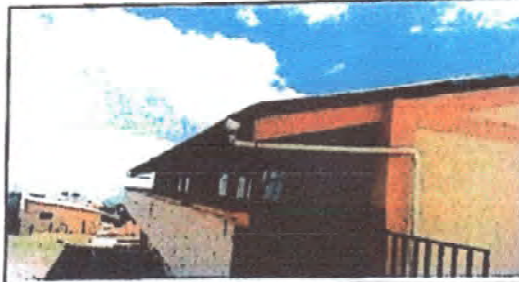
Foto 4: Sustrucción de canal de metal
