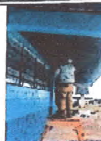
Foto 2: Sustrucción de vidrios
